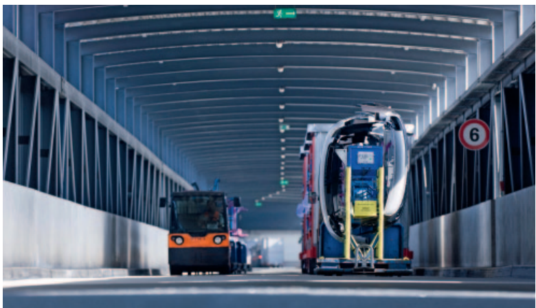
Eine Brücke verbindet das Audi-Werksgelände mit dem benachbarten Güterverkehrszentrum und ermöglicht eine Just-in-Sequence-Materialanlieferung an die Montagelinien.
